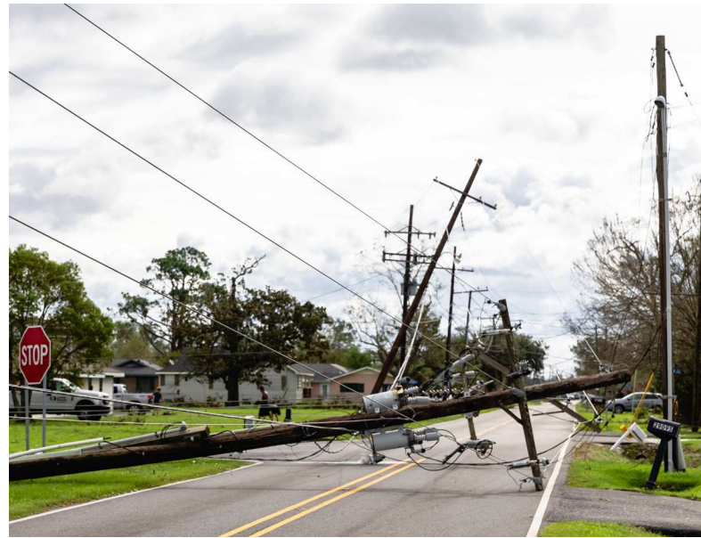
Quanta Services: Bei einem Strommast-Unfall hilft die US-Firma.
